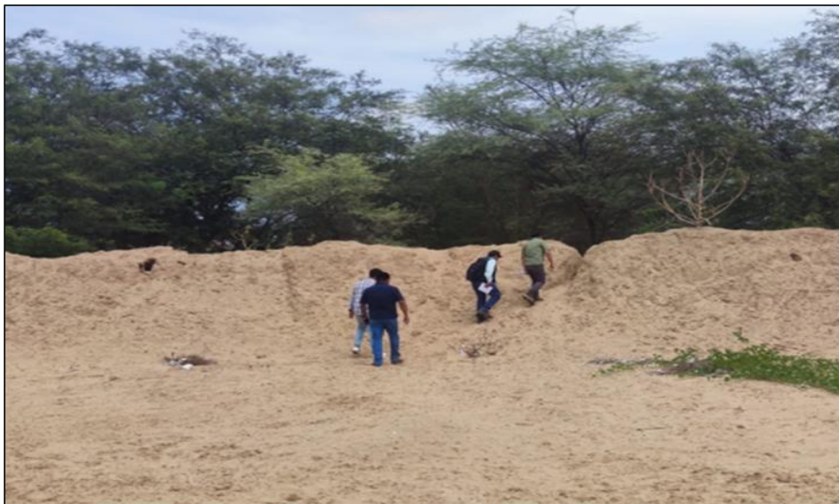
Figura N° 03: EN LAS TEMPORADAS DE MAXIMAS AVENIDAS LA QUEBRADA SAN FRANCISCO SE DESBORDA POR LA MARGEN DERECHA, CUYO TRAMO SE ENCUENTRA COLMATADO Y DESPROTEGIDO, LO QUE LA HACE VULNERABLE A LAS VELOCIDADES EROSIVAS DE LA CRECIENTE.
